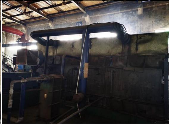
蒸发油雾收集装置管道
