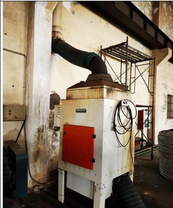
蒸发油雾废气处理装置
